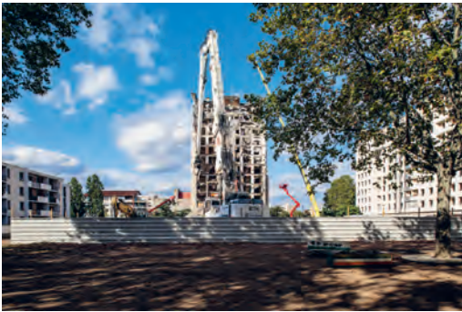
La tour 54 Carnot, démolie en 2019
